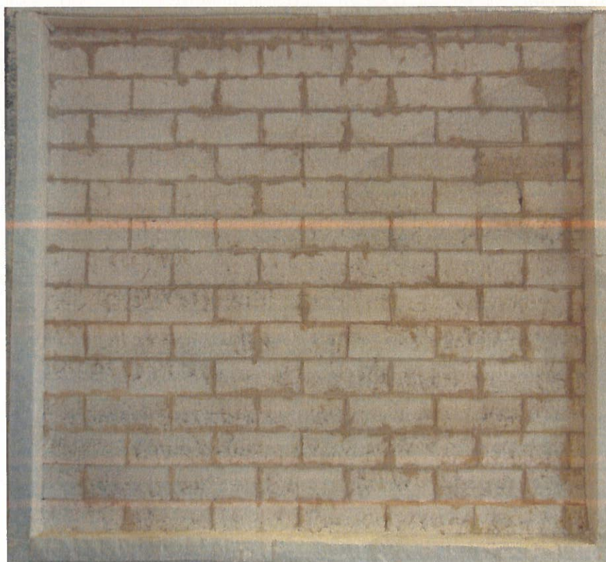
Foto 6: Lato esposto al termine della prova
