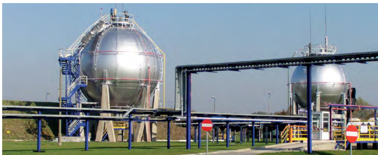
Tradycyjnie LPG jest przechowywany w zbiornikach kulistych. Każda tego typu kula może zawierać około 1000 ton LPG.
