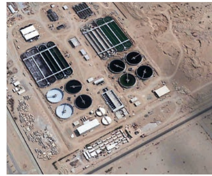
Satellitenbildaufnahme zu Beginn der Montage (© 2012 Google, image © 2010 GeoEye)
