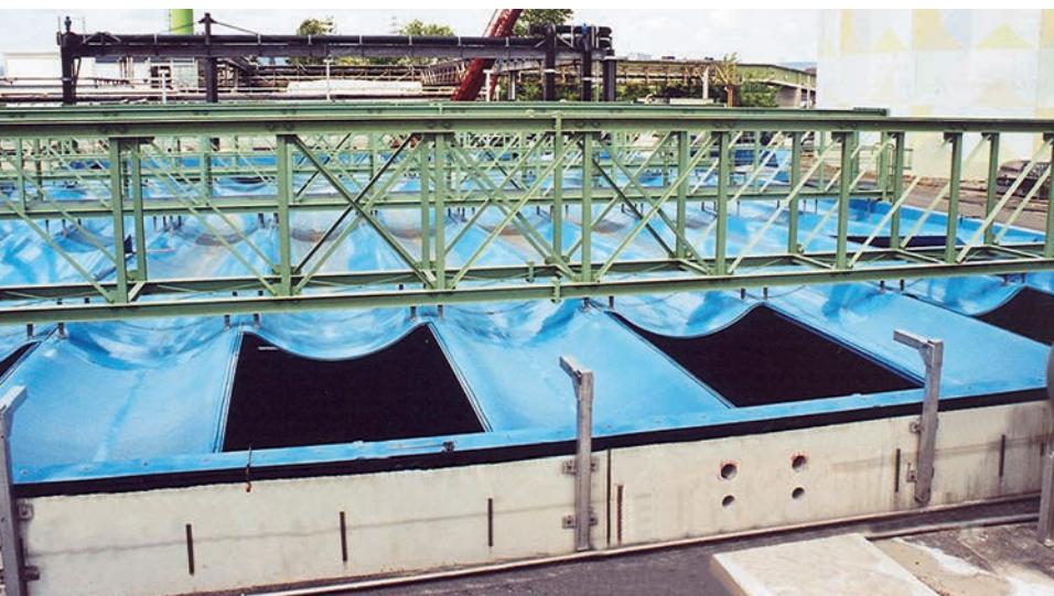
Infraserv, Wiesbaden, Binderspannweite 25 m, Elementspannweite bis 8 m
