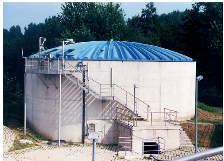
Typ E2, Kuppel in Hückelhoven, 20 m Durchmesser
