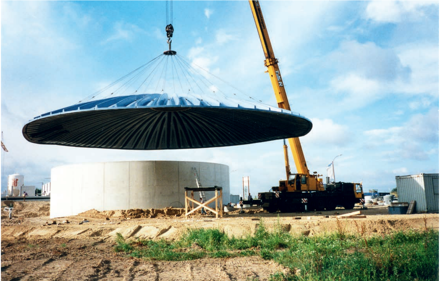
Aufsetzen einer vormontierten Kuppel mit Mobilkran
