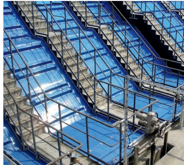
Typ L, Schneckenpumpwerk in Cottbus
