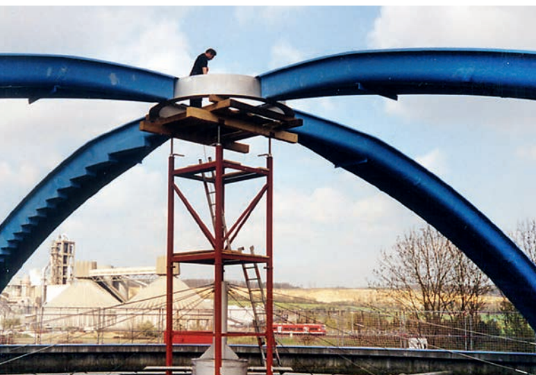
Montageturm im Becken
