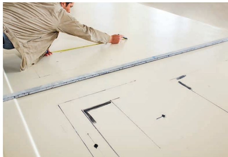
Markierungen für Tragrippen bzw. Metalleinlagen
