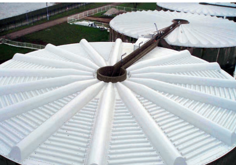
Typ G5, Rundbecken mit 37 m Durchmesser in Crossness/London
