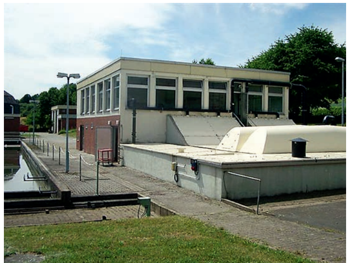
Pultartiger Gebäudeanschluss; flacher Teil mit Revisionsklappen und Trägerschalen
