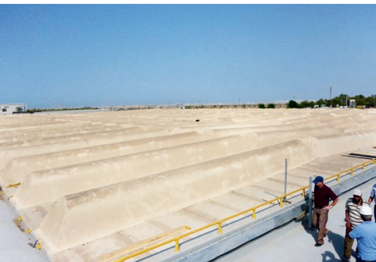
Alle Bilder dieser Reihe: Abdeckungen für 8 Belebungsbecken (je 155 x 30 m) während der Montage
