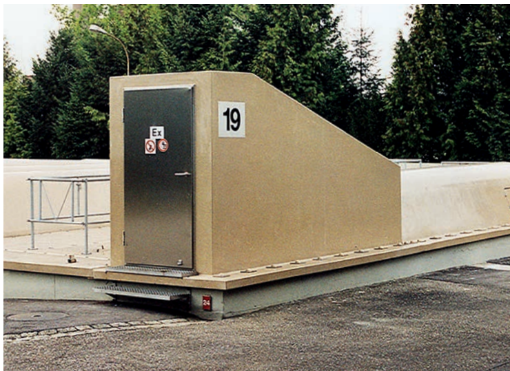
Treppenabgang ins Beckeninnere
