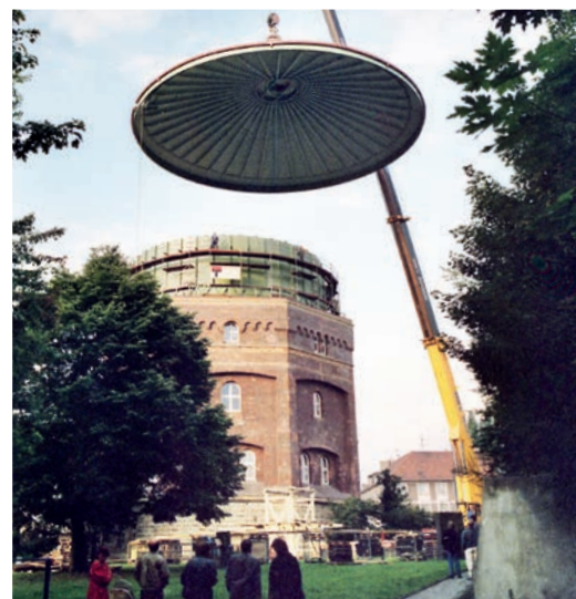
Aufsetzen der vormontierten Kuppel in Essen
