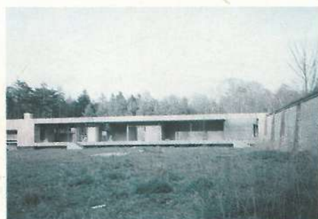
Stéphane Beel, Villa M., Zedelgem. Vue du chantier.
