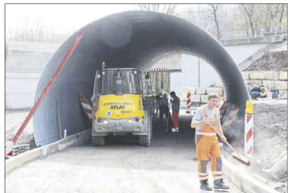
Wegen Asphaltarbeiten ist der Durchlass am Montag für den Verkehr gesperrt.
