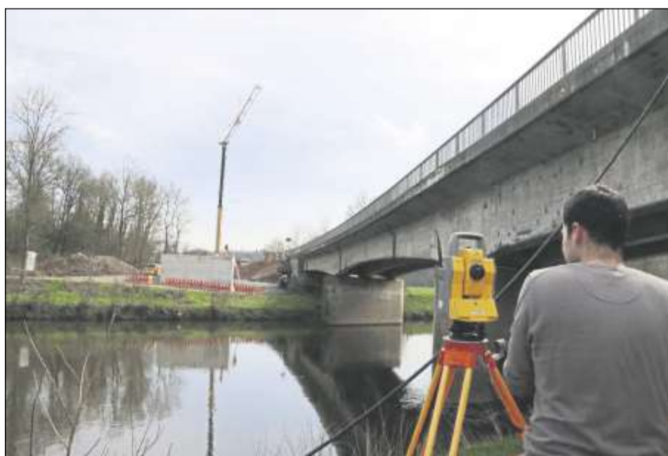
Der Damm ist aufgeschüttet und die zwei Widerlager im Egelsee sind gebaut.
