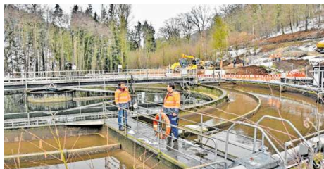
Daniel Berger (links), neuer Leiter der Kläranlage in Hardheim, wird von seinem Vorgänger Rolf Kaufmann tatkräftig unterstützt. Das Bild zeigt sie vor dem in die Jahre gekommenen Klärbecken. Im Hintergrund laufen bereits die Erweiterungsarbeiten.
