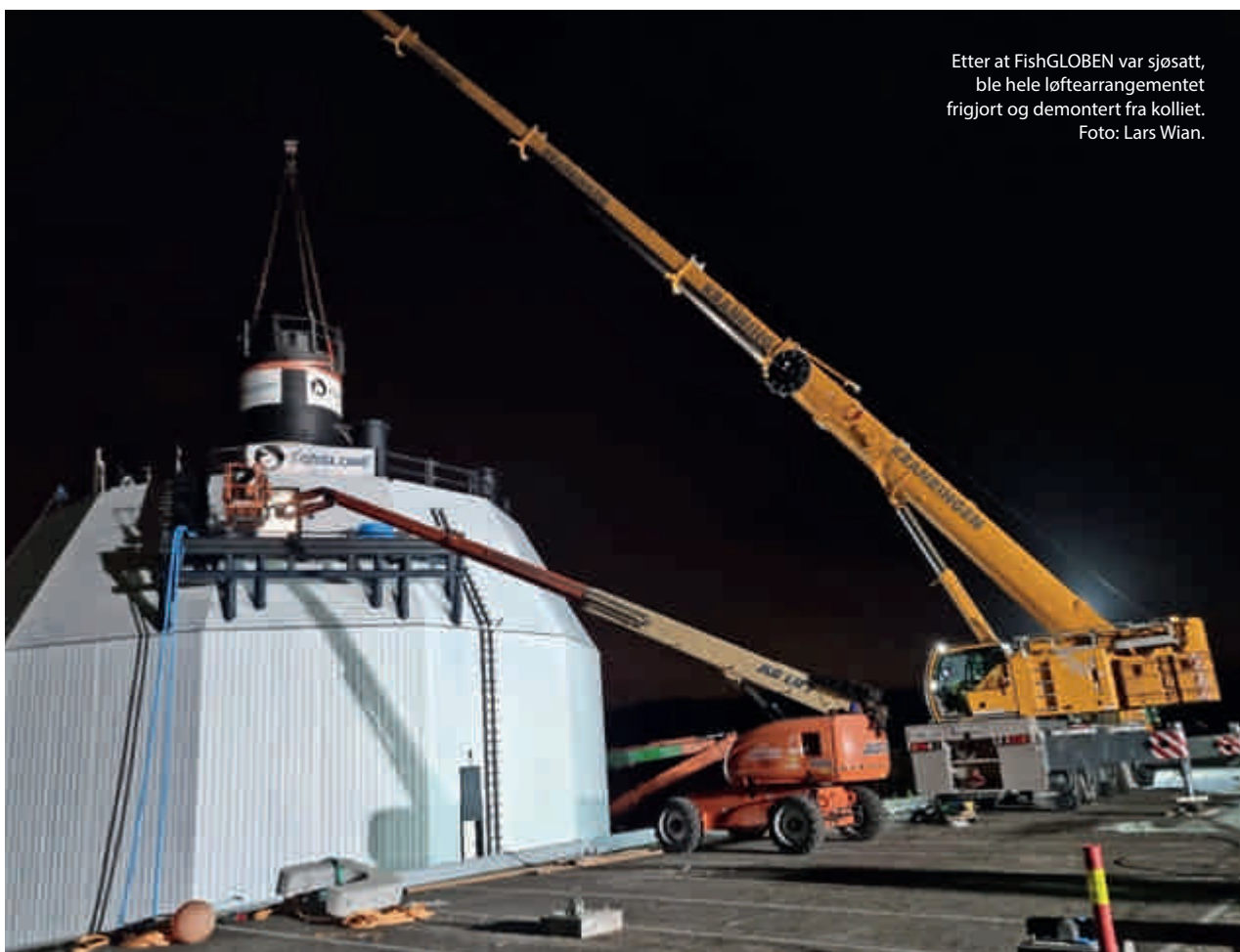
Personell observerer med våkent øye om kolliet løfter seg i likevekt fra pilarene. Foto: Lars Wian.
