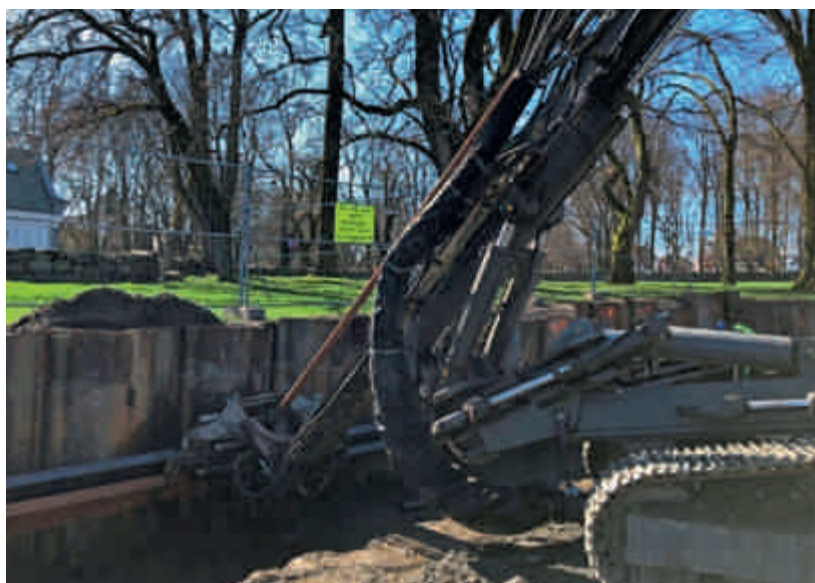
Krevende spuntejobb i dyp byggegrop på Ledaal i Stavanger.
