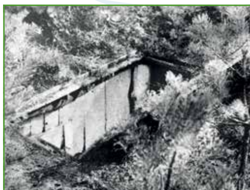
Het luik dat toegang geeft tot de joden-schuilplaats
