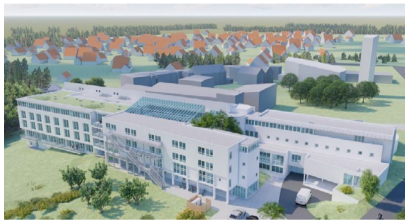
Haus Laurentius nach Umbau und Neukonzeption (unverbindliche Illustration) Foto: EHS
