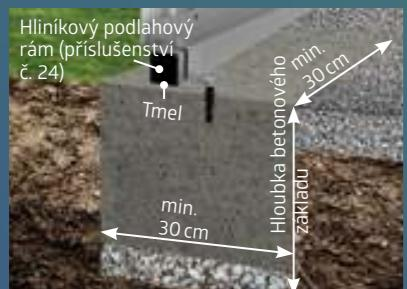
Další možností instalace zahradního domku Biohort na nerovném a měkkém povrchu je betonový základ v kombinaci s **hliníkovým podlahovým rámem**, čímž domek bezpečně ukotvíte proti bouři.
