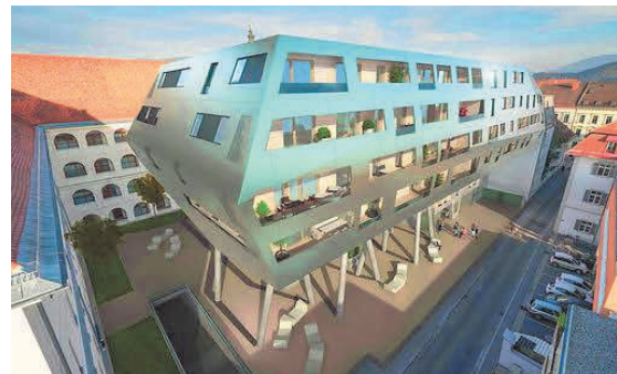
Der Neubau bekommt eine markante Alufassade © KK
