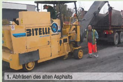
1. Abfräsen des alten Asphalts
