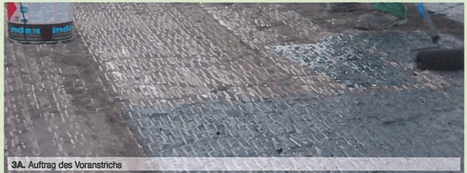
3A. Auftrag des Voranstrichs
