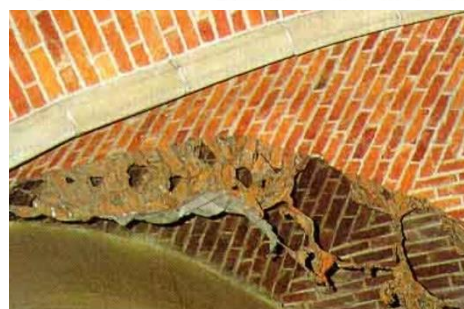
Nettoyage de brique
