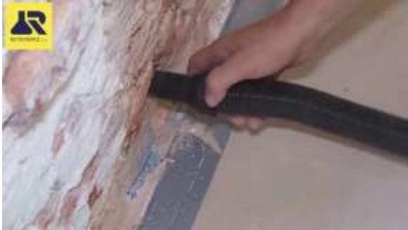
Dépoussiérer, aussi dans les trous de forage
