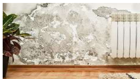
Efflorescences de sel
