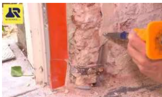
Décaper les enduits autour des canalisations
