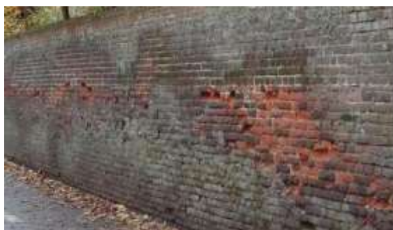
Pulvérulence des briques et des joints de mortier
