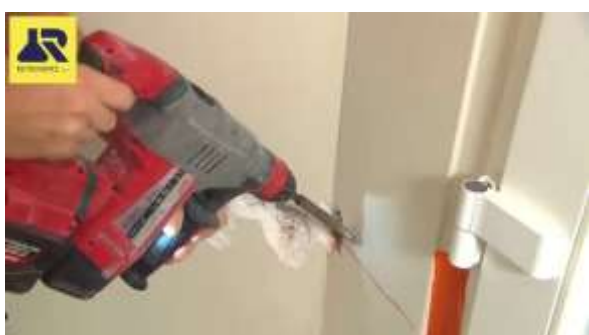
Décaper les enduits
