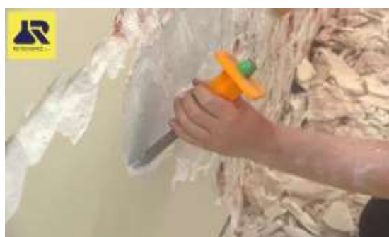
Décaper les enduits
