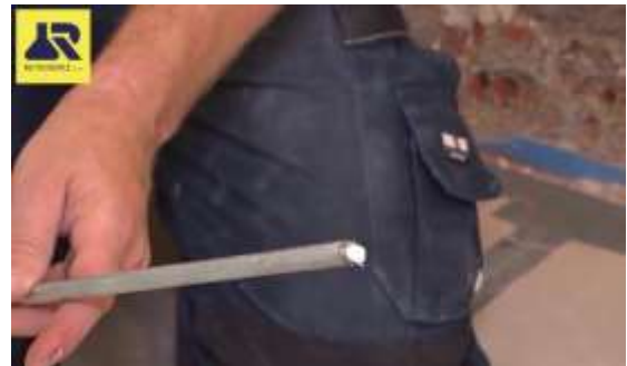
Presser la gâchette du pistolet jusqu'au moment où le gel sort de l'orifice de la buse
