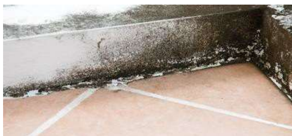
Pulvérulence des briques et des joints de mortier
