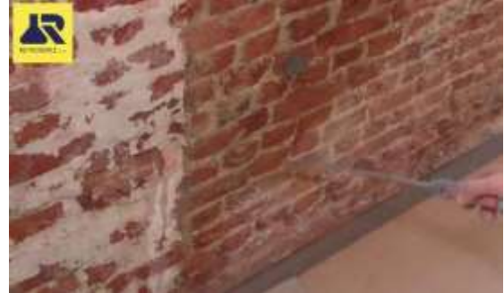
Appliquer RC Sulfastop ZB ou RC NITRABLOCK aux endroits où les sels sont présents
