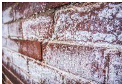
Efflorescences de sel
