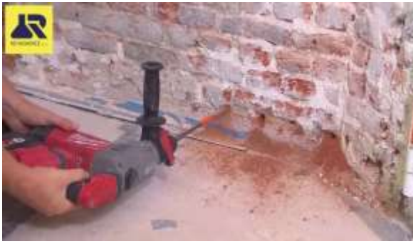
Forer des trous: \varnothing 12 mm ou \varnothing 14 mm
