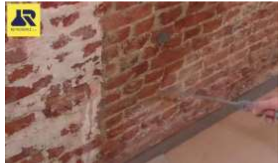
RC Sulfastop ZB of RC Nitrablock aanbrengen bij aanwezigheid van zouten
