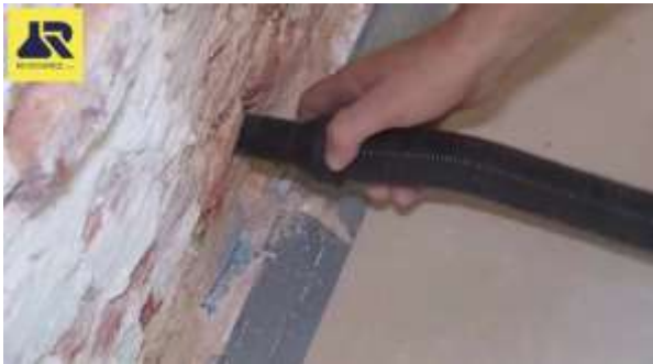
Verwijder alle stof, ook in de boorgaten
