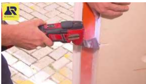
Hoekprofielen verwijderen
