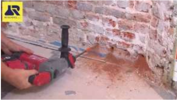
Gaten boren Ø12 mm of Ø14 mm
