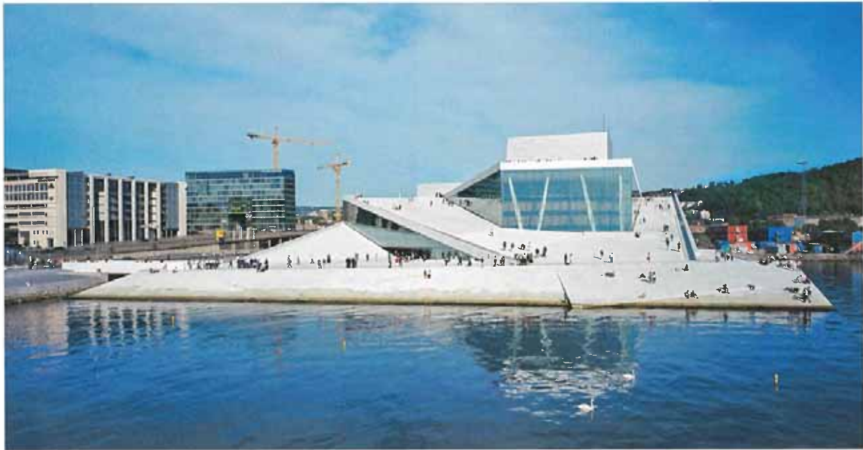
Nationaloper von Norwegen, Oslo (Architektur Sørhetta): Fließende Übergänge von innen nach aussen fügen sich zu einem Erlebnisraum nach menschlichem Mass und zu einer differenzierten Komposition von Mensch und Ereignis.
