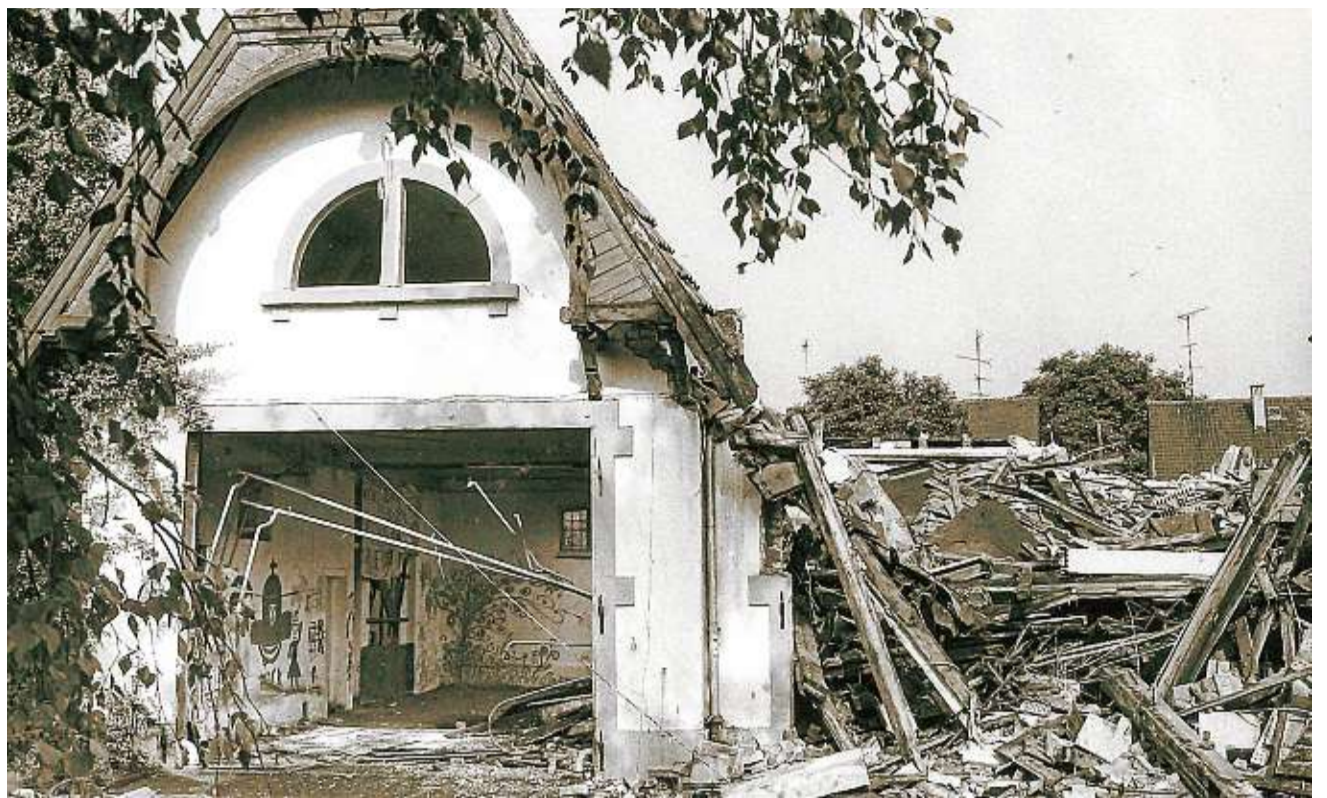
Nach der Räumung rollte der Bagger an: Die jugendlichen Besetzer mussten mitansehen, wie die Stadt aus dem Feuerwehrgerätehaus in kürzester Zeit eine Ruine aus Staub, Brettern und ein paar Ziegeln machen ließ. BILDER: SK-ARCHIV (2)
