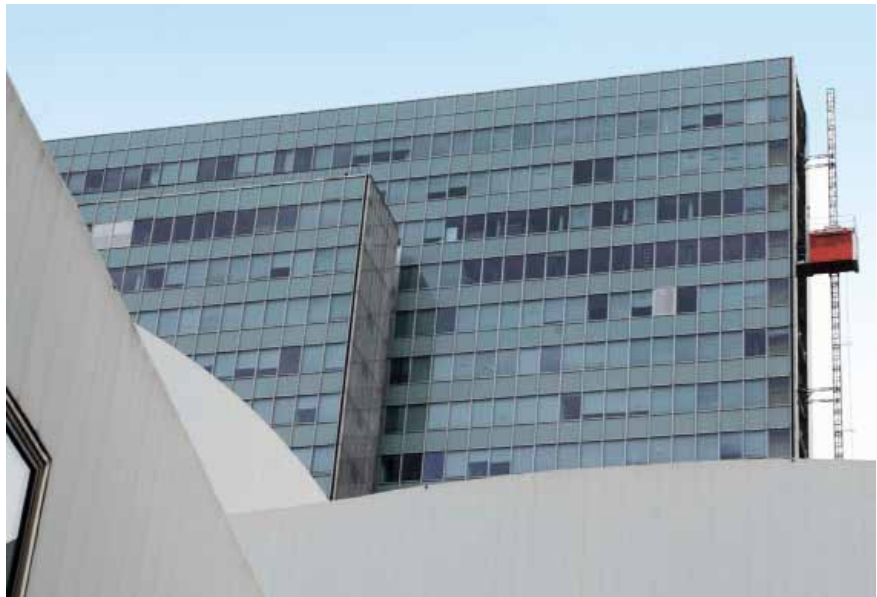
Die Düsseldorfer Immobilie vor dem Refurbishment.
