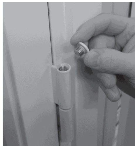
Fig 21. Demontering av dekklokk på toppen av hengsler.
