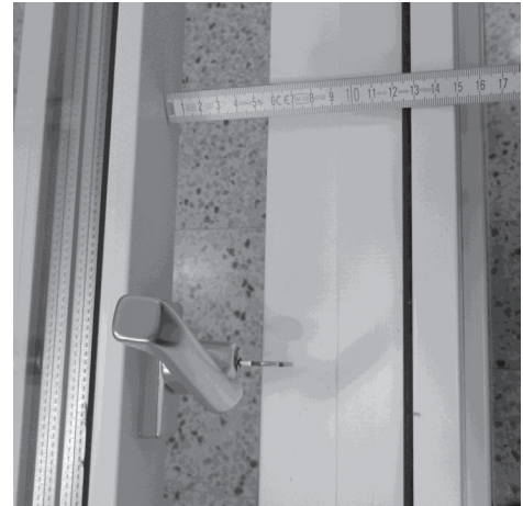
Fig 24. Åpningssperren skal stoppe vindusrammen slik at åpningen ikke overstiger 10 cm.
