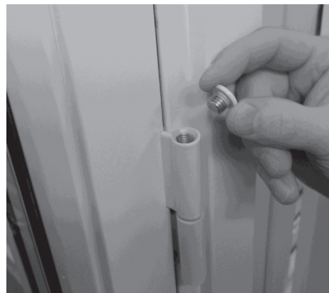
Fig 37. Slik fjerner du dekkklokken på toppen av hengslene.
