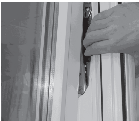
Fig 25. Dytt/trekk sperren for beslaget mot deg for å åpne vinduet helt.
