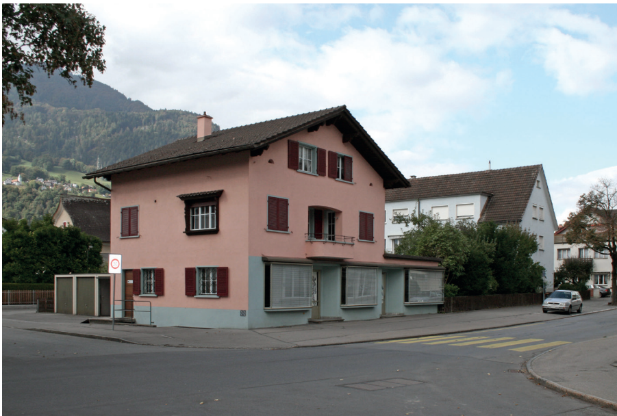
Bestand Mehrfamilienhaus Plantahofstrasse/Schulstrasse
