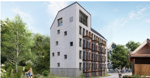
Abbildung 2: "FELZ ZWEI" befindet sich an der Girhaldenstrasse 20 in 8048 Zürich. Quelle: www.vbau.com .
