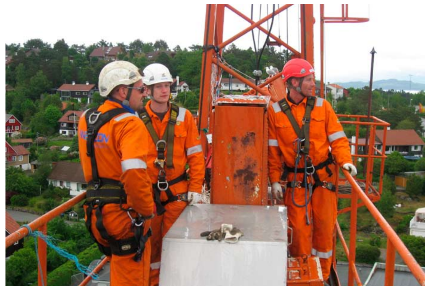
Klar for demontering av kranen på Stord. Fra venstre Jan Eivind Osmundsen, Dag Kåre Larsen og Morten Svelland.
