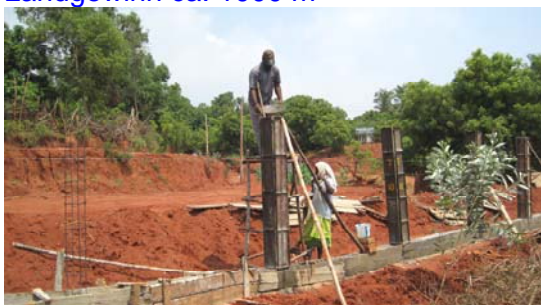
21. Sept.: die ersten Pfeiler werden ge- gossen
