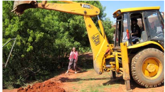
Erster „Spatenstich“ 8. Sept. 2009
