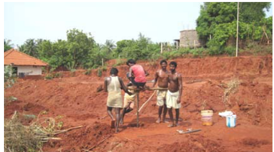
Harte Arbeit, den Bohrer auf diese Art 1.6 m in die Tiefe zu bringen
