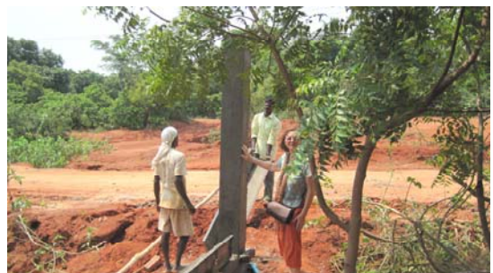
Der erste Pfeiler wird ausgeschalt
