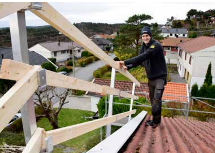
Med planker i 48 x 98 mm som fotlist, knelist og rekkverk, får vi nødvendig sikring her oppe, demonstrerer Sørheim.
